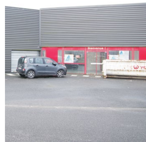
La SICA s'installera dans la partie droite du bâtiment, à côté de la parapharmacie « Graine de Coton »
