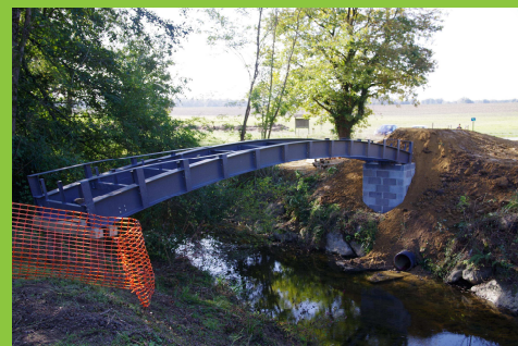
La nouvelle passerelle vient être installée
