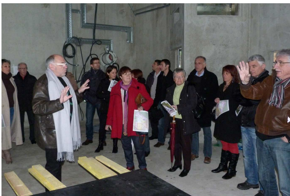
L'architecte Cyril Despré (à gauche), a fait le point avec les élus concernant l'évolution des travaux la Maison de la Musique, dont l'achèvement est prévu pour cet été.
